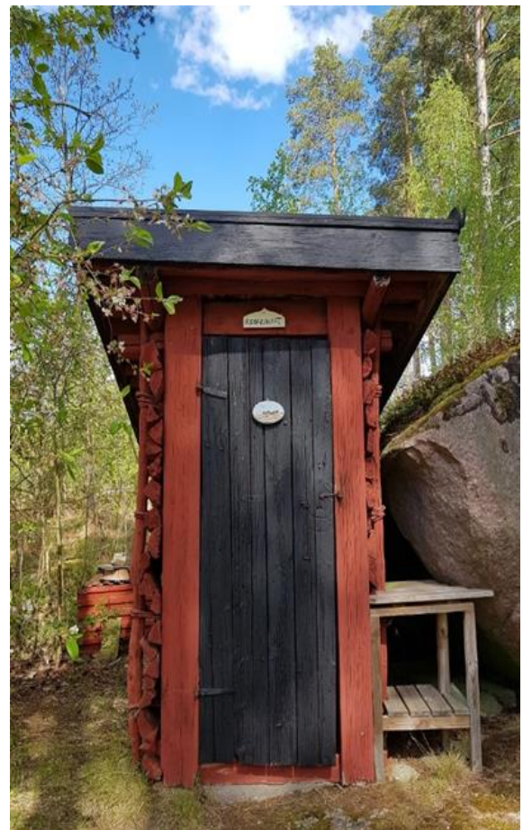
Dassets långsidor är byggd som en hängad gärdesgård.
